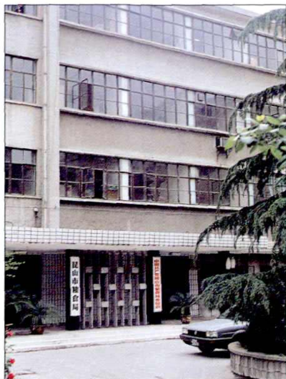
昆山市粮食局机关大楼
