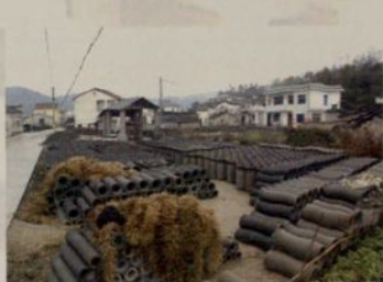
水泥构件生产
