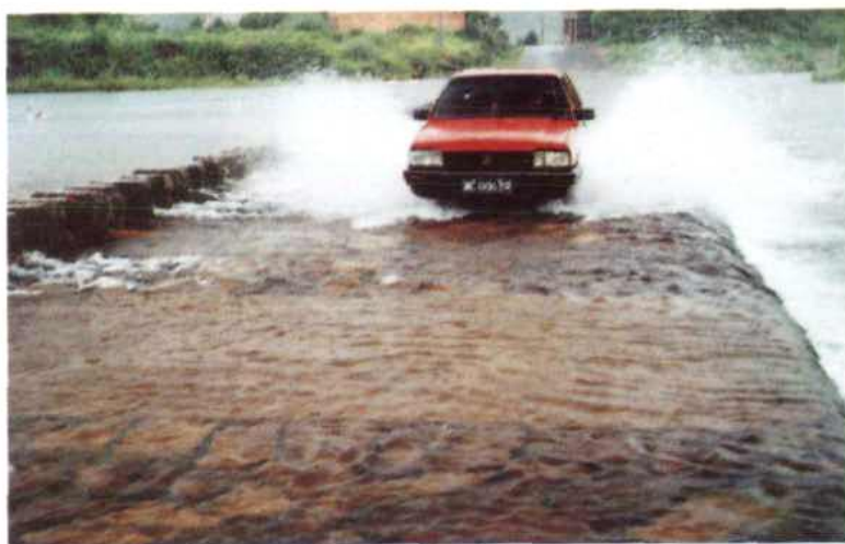
莒(江)百(丈口)公路 仁石段过水路面
