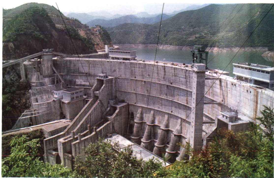
紧水滩水力发电厂
