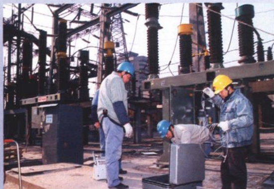
2003年1月，升压站大修现场
