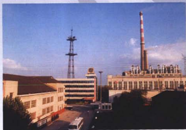
南京热电厂主厂房 (2005年9月摄)
