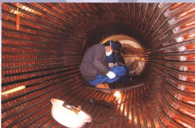
2002年12月，5号机组大修（发电机定子膛改造）
