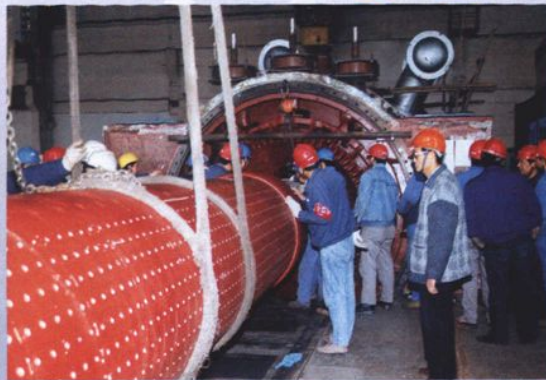
2003年3月，5号机组改造性大修(穿转子)
