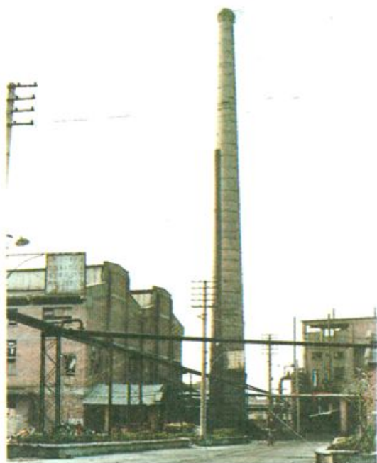
● 池炉、造气车间外景
