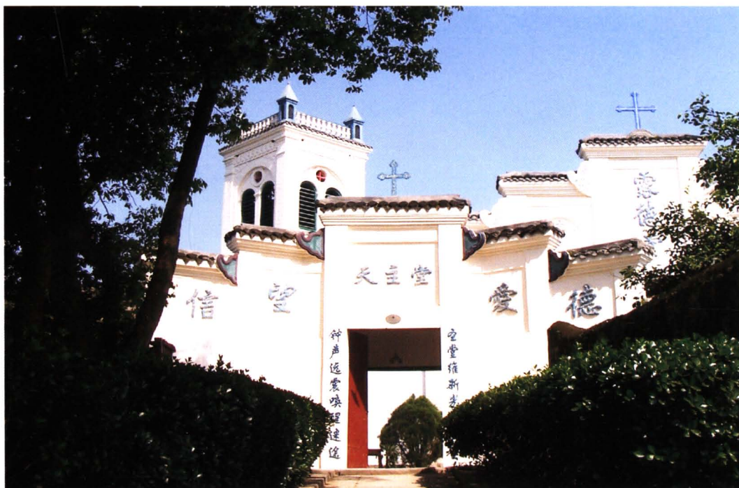
修复后的露德堂
