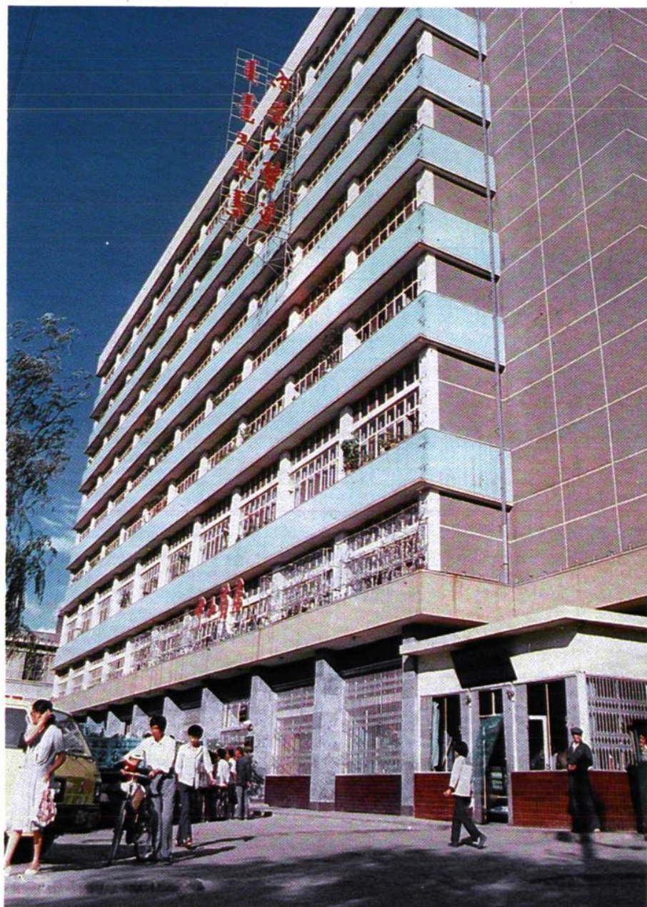
内蒙古医药大楼 一至五层为呼和浩特医药分公司 (一二层为医药零售门市部)
