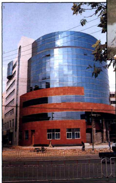
即将竣工的浙西农资公司大厦
