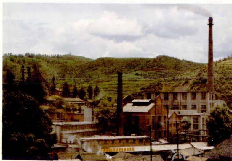
2×6000 千瓦羊场煤矿 研石电厂
