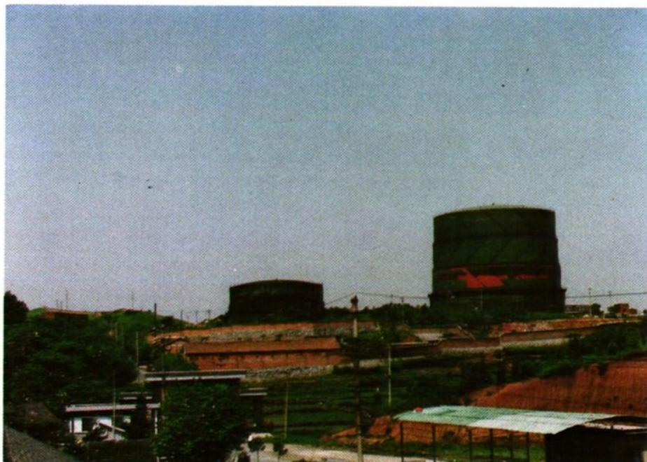
市煤气公司的两座储气柜。容积分别为2万立方米和5.4万立方米。
