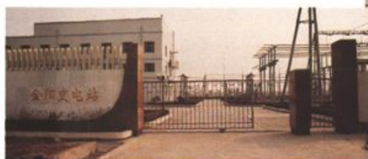
220kV 金阳变电站
