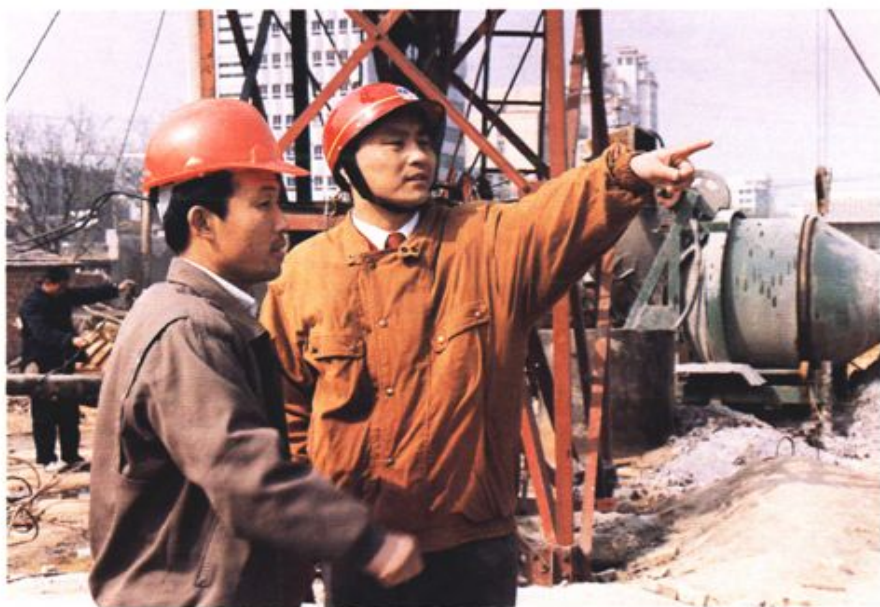
原泰安电业局局长，现山西省电力公司总经理陈进行（右一）现场指挥生产
