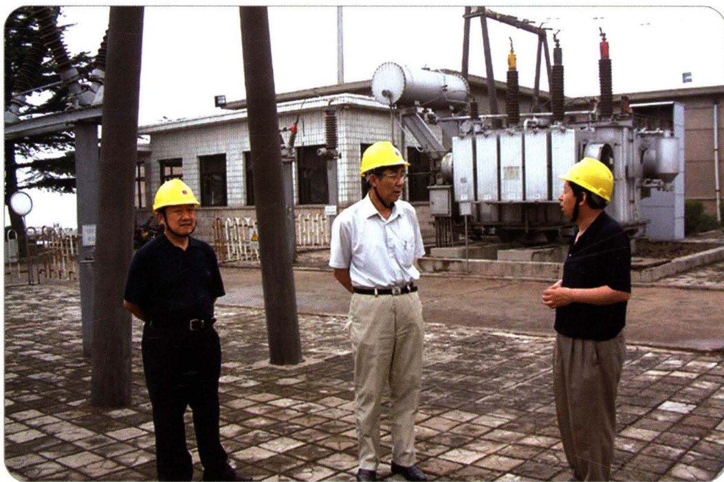
2006年6月，日照供电公司党委书记缪建东（中）视察公司变电站。
