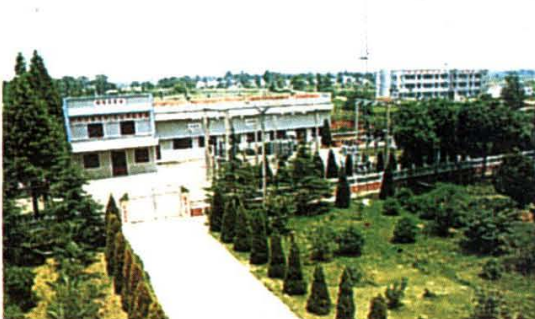
垌冢 35KV 变电站
