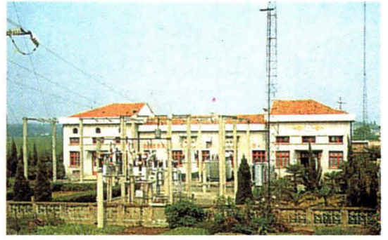
杨林 35KV 变电站
