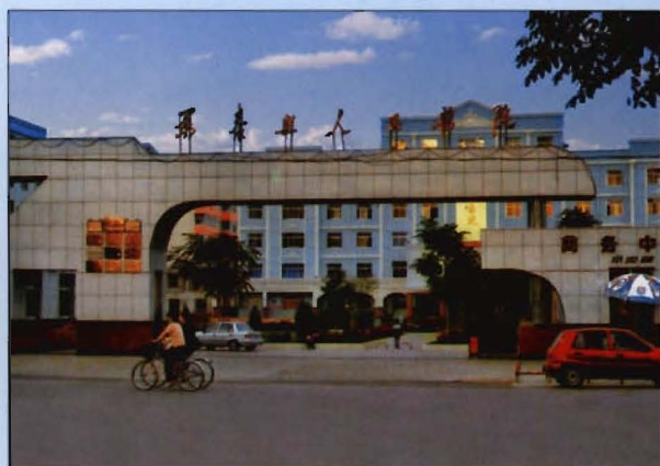
景泰县人民医院
