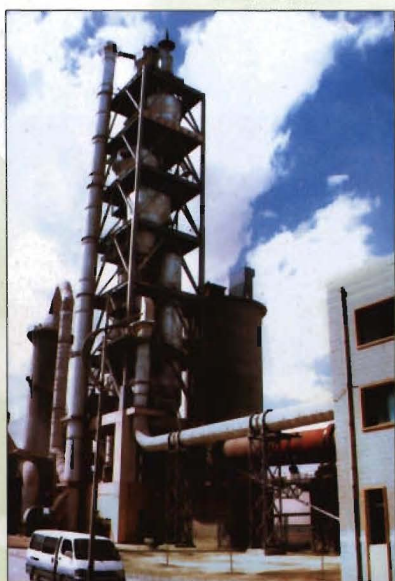
寿鹿水泥公司新型干法熟料生产线
