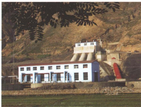
◆ 虎家崖电站机房
