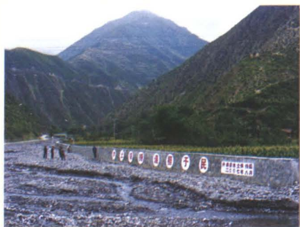
◆水土保持工程
