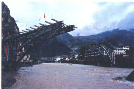
◆ 在建中的城江大桥
