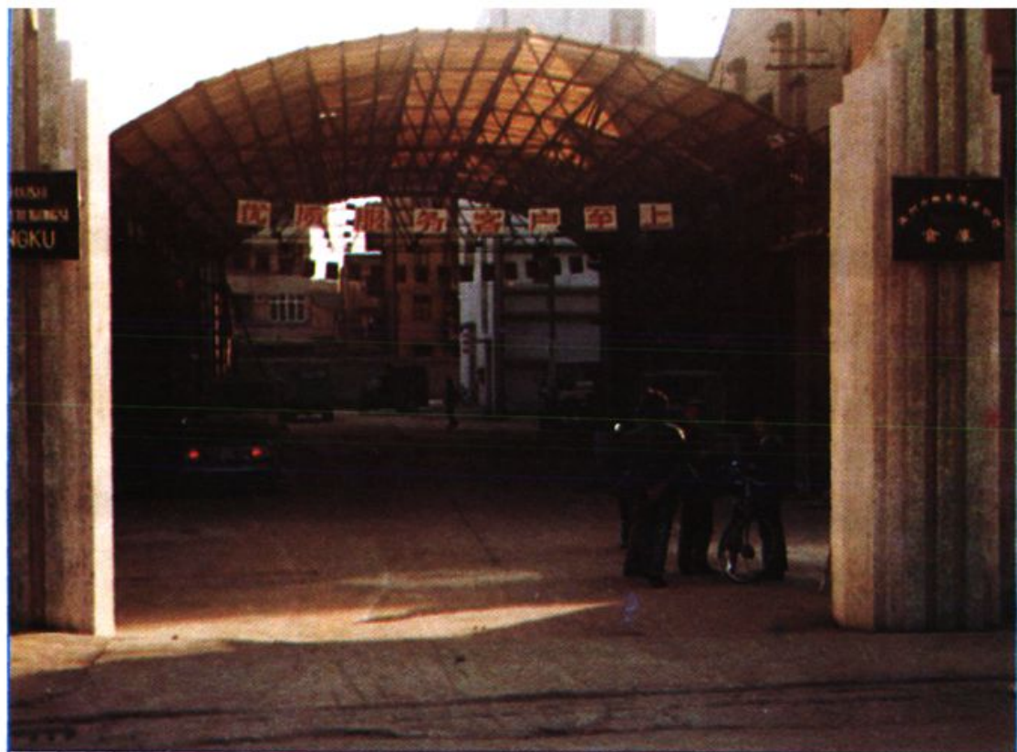
温州市机电设备公司灰桥仓库
