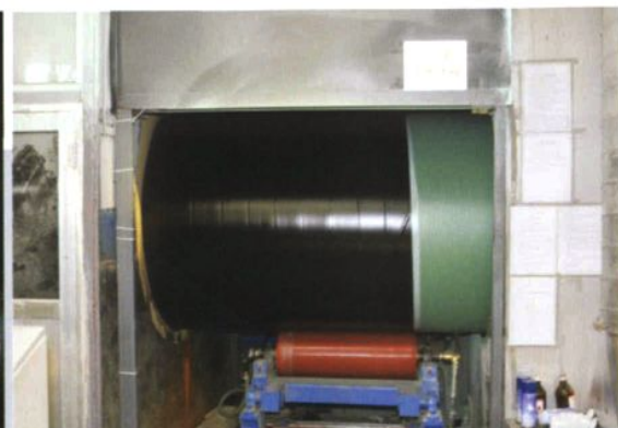
防腐缠绕工艺
