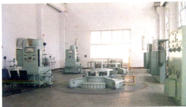
困难县扶持项目——百丈水库电站（1994年7月6日）。
