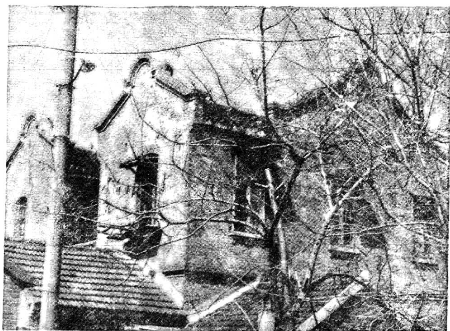
1913年荣泰电气股份有限公司发电厂房
