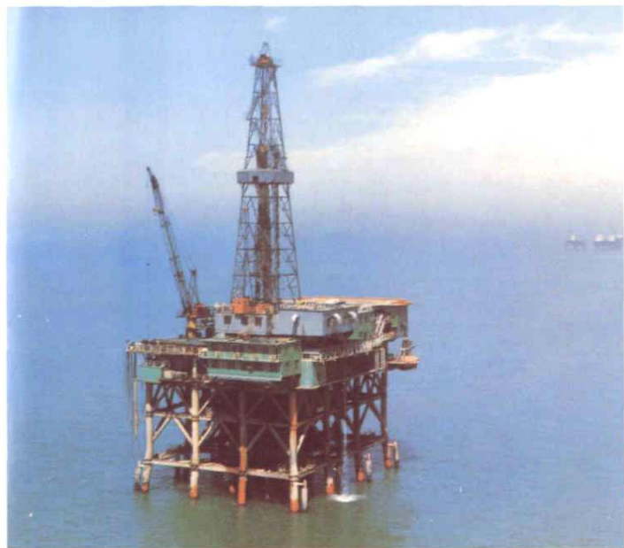
兰州石油化工机器厂产品钻井平台在南海(1988年摄)
