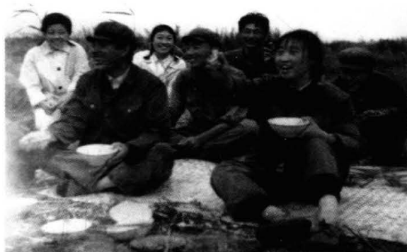
当年马场人发扬不怕苦、不怕累的精神，干在工地、吃在工地的场景。
