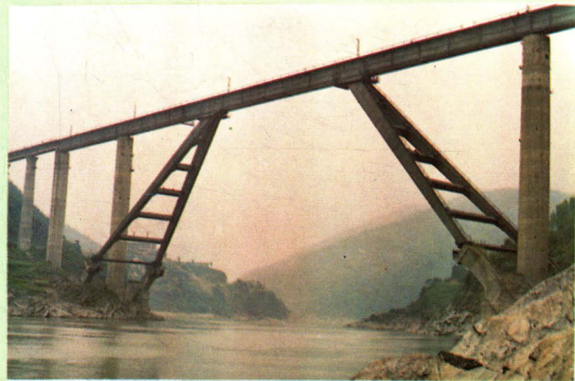
宝鸡桥梁工厂生产的加薄壁箱型钢桥梁 ——汉江斜腿钢结构桥
