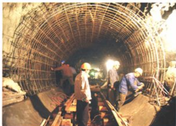
高桥电站隧洞施工
