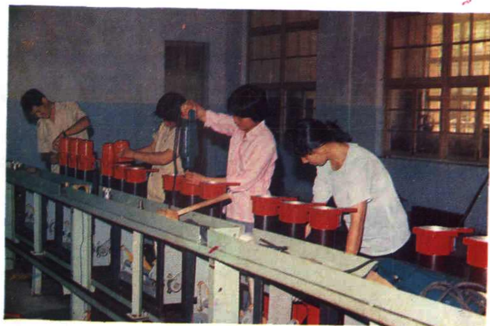
元件车间工人师傅正在装配、调试油开关
