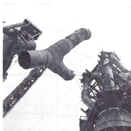
重钢扩建工程 3 号、4 号高炉在吊装
