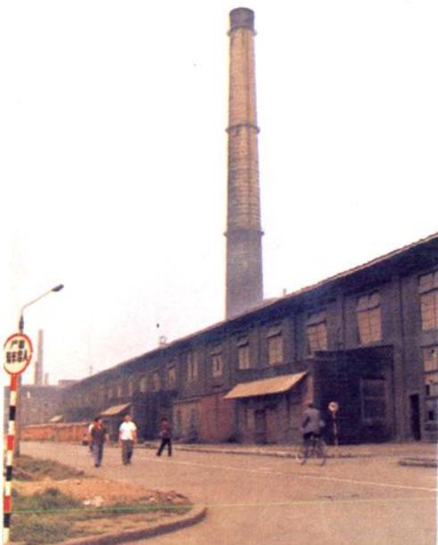
1954年9月抚顺铝厂建成。图为120米钢筋混凝土烟囱。
