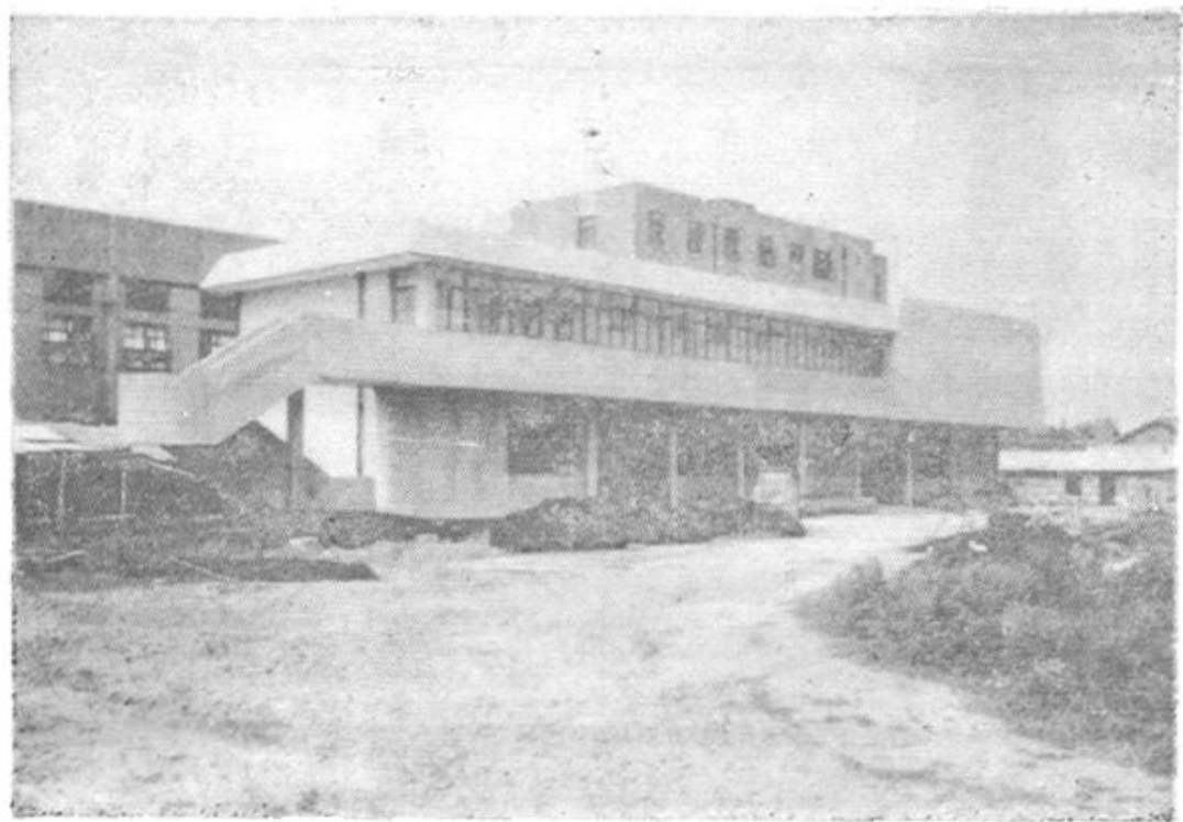
建造中的上海五香豆廠浦東新廠址
