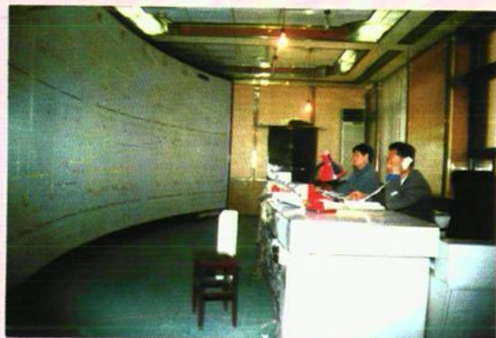
1998年的武安电力调度室
