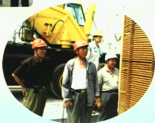
2003年6月12日，后坡35千伏 变电站安装现场
