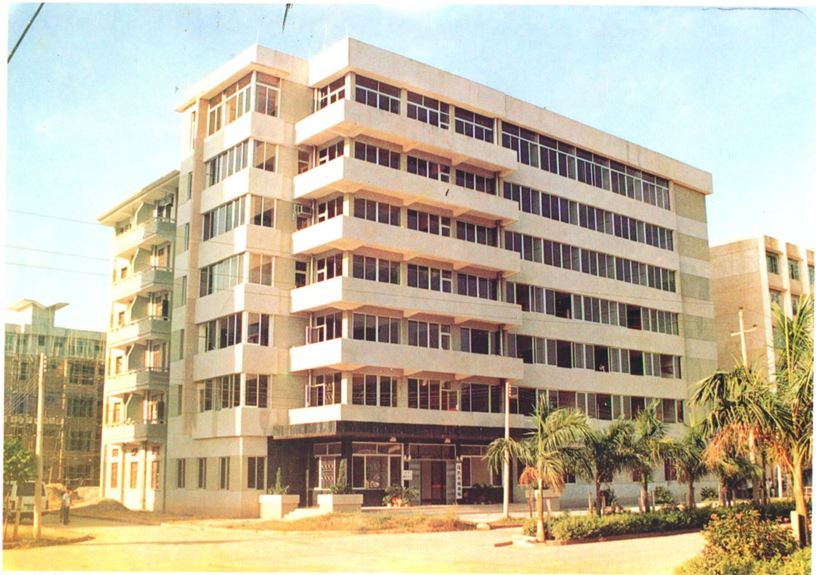
茂名市税务局办公大楼，地址：油城六路 建于1987年12月
