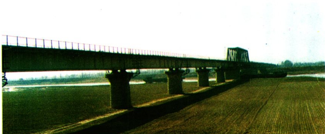
新兖铁路运河大桥
