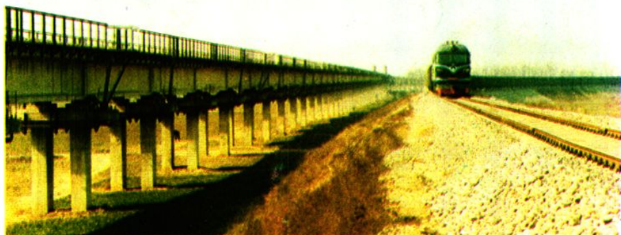
兖石铁路及兖石疏解线特大桥
