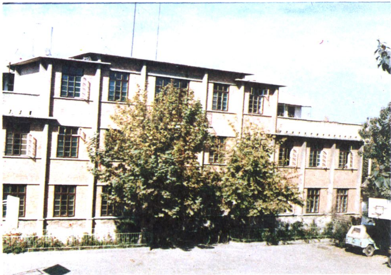
地区粮食局办公楼
