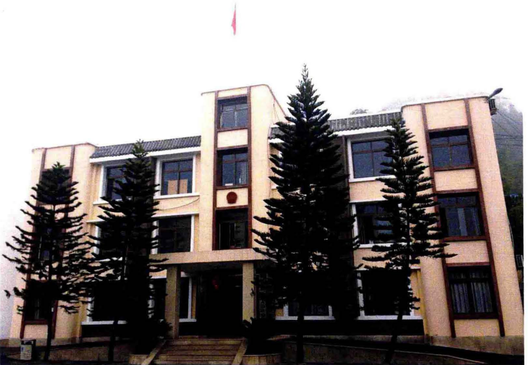
政府办公大楼
