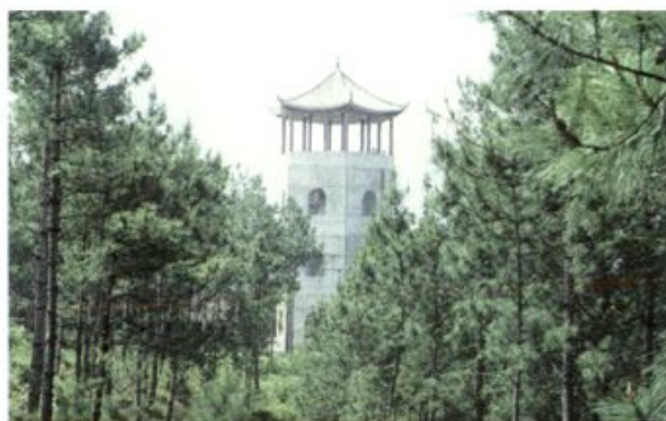
市中区东坝办事处黑石坡林场护林防火了望台
