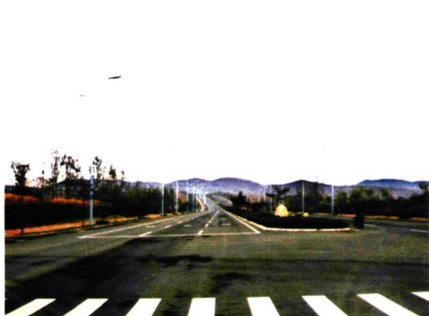
开发区道路建设
