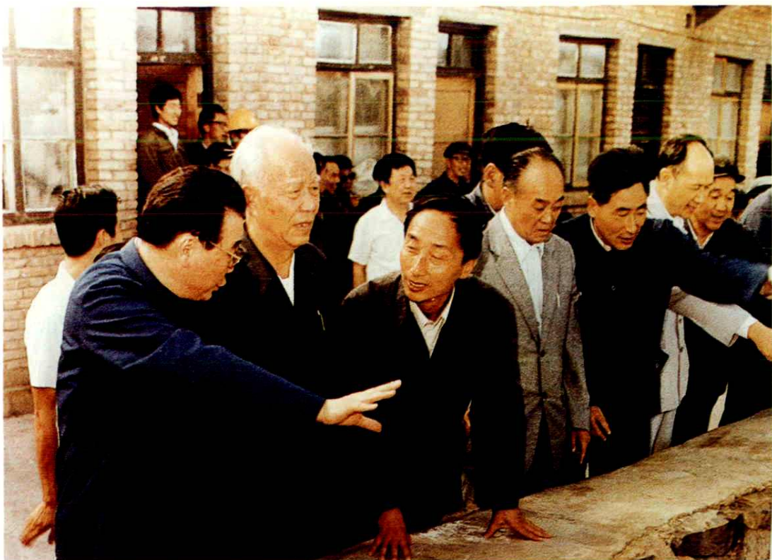
◆ 1984年6月, 国务院副总理万里、李鹏视察龙羊峡建设工地
