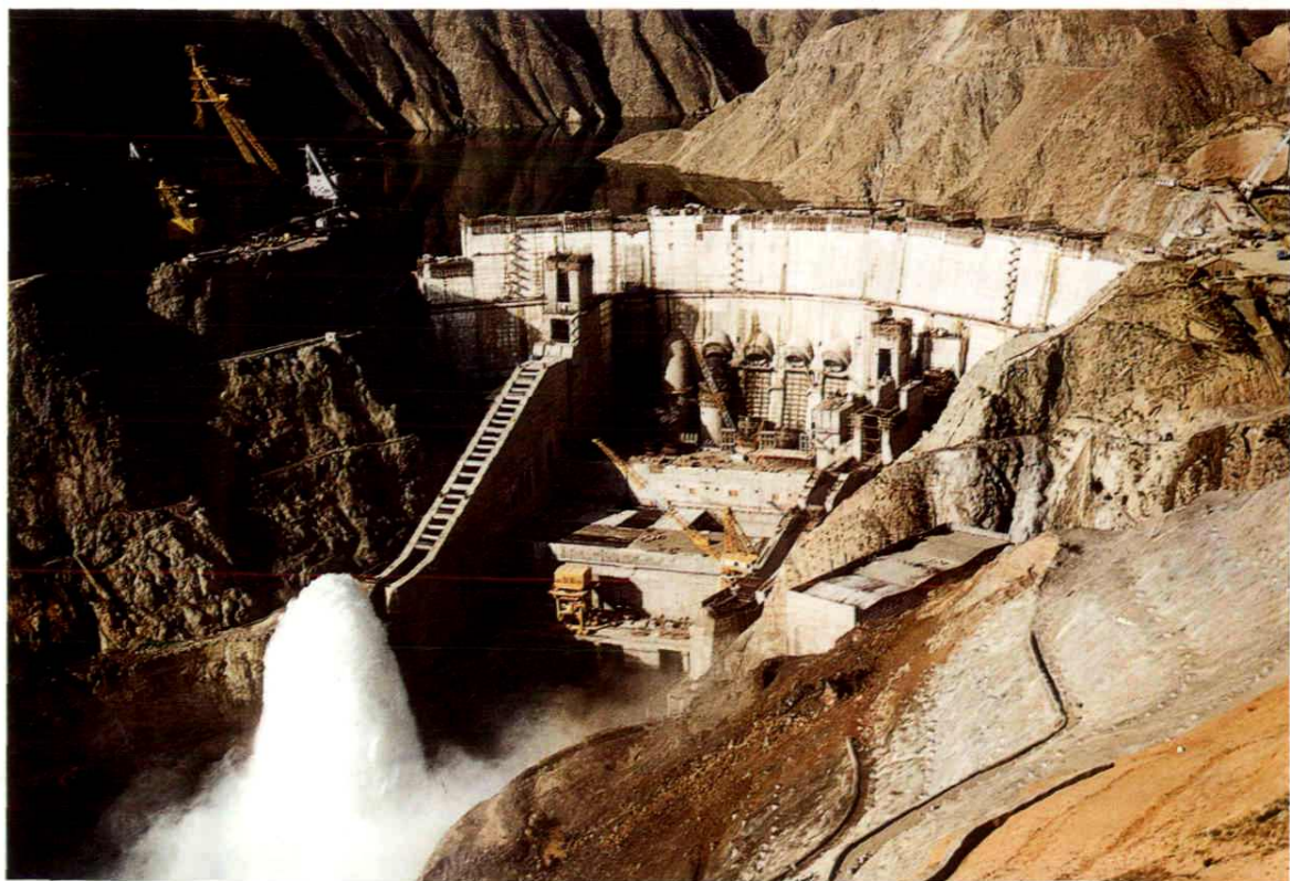
◆ 黄河李家峡水电站
