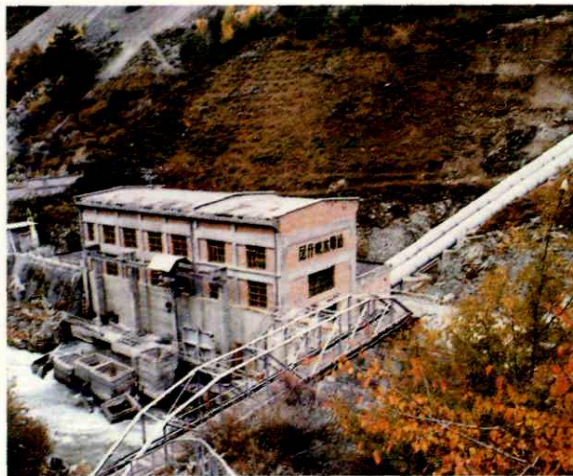
◆甘肃白龙江尼什峡水电站厂房
