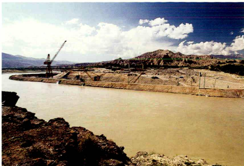
◆黄河尼那水电站开工准备工作
