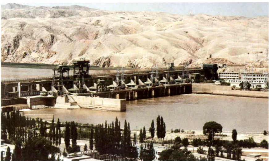
◆ 黄河青铜峡水利枢纽
