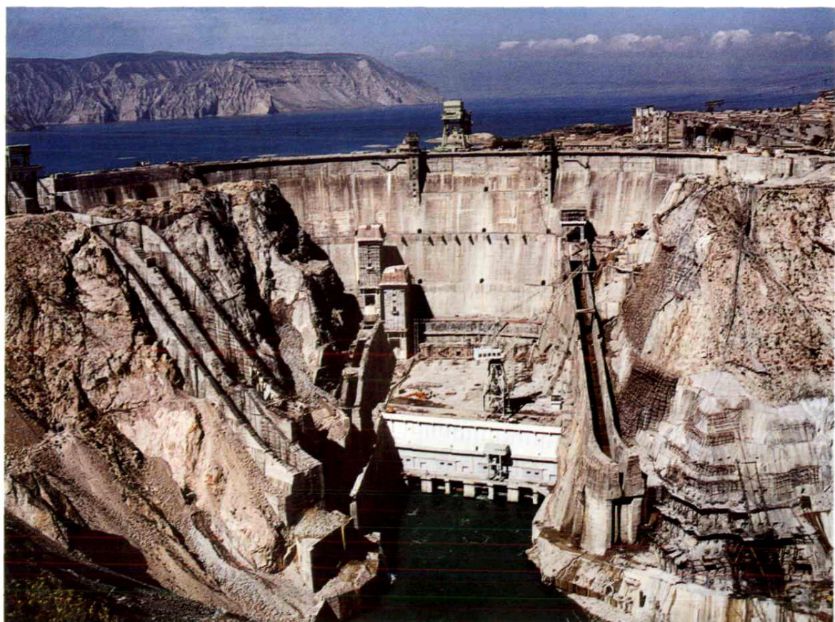
◆ 黄河龙羊峡水电站
