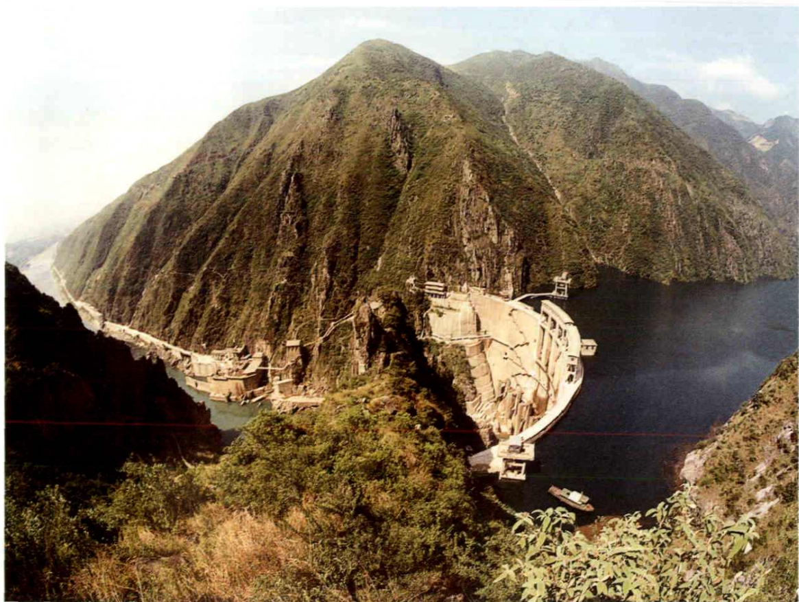
◆陕西襄河石门水电站
