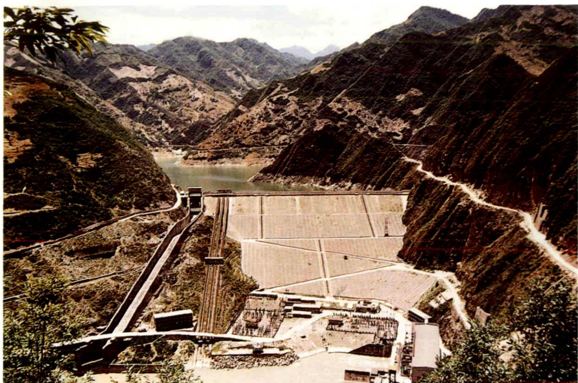
◆白龙江碧口水电站
