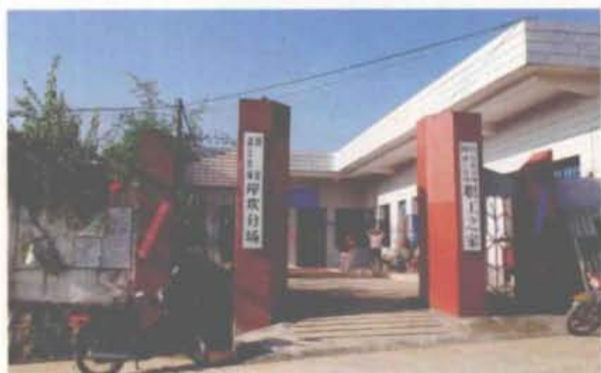
岸坎分场办公楼
