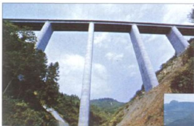
顶天立地——2002年建成的洗壁溪大桥，湖南省当时最高的公路T型梁桥
