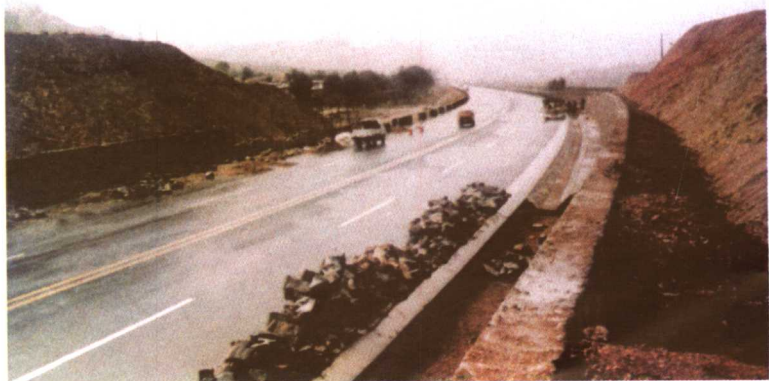
图为“207国道”膳房堡至孔家庄段道路拓宽改造工程一角。
