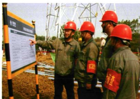
2006年，组织施工人员开展施工现场安全学习
