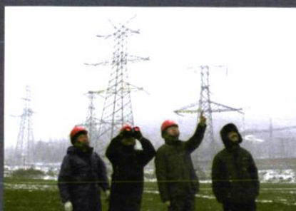
2005年，巡线人员开展雪天特殊巡线
