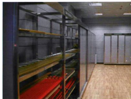
2007年，新建带电作业工具库房
