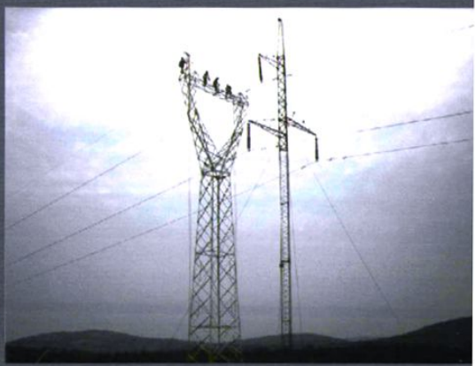
2006年11月，对220千伏荆（门热电厂）胡（集）线进行老旧线路改造
