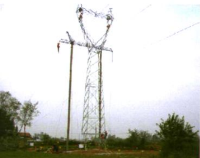
2006年，对220千伏荆（门热电厂）枣（山）I回微气象区进行改造
