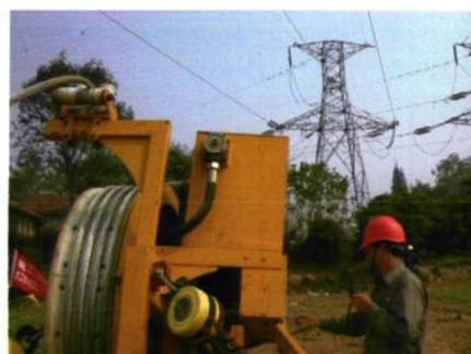
2007年，首次完成220千伏双（河）郢（中）II回跨江段导线更换施工
