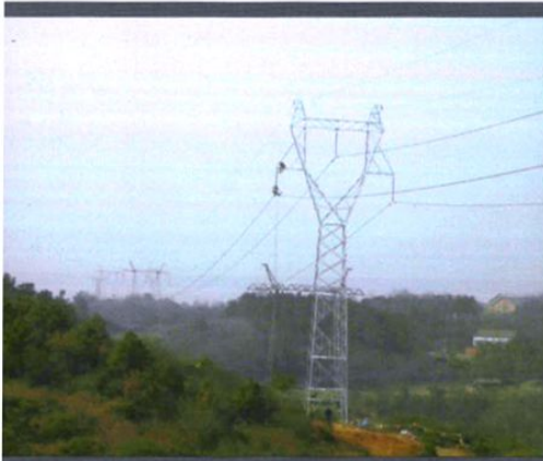
2005年7月，对220千伏双（河）家（马家塆）线进行老旧线路改造
