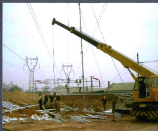
2005年，荆门供电公司输电线路部配合荆门热电厂三期工程建设，完成220千伏荆（门热电厂）双（河）I、II回、荆（门热电厂）胡（集）线1~3号移位新立铁塔施工
