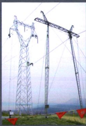
2005年12月，对220千伏胡（集）双（河）I回进行老旧线路改造
