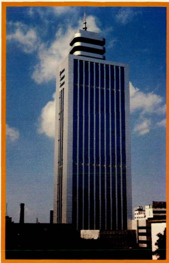
由公司承建的山西电力调度大楼
