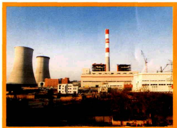
由公司建设的河津电厂一期工程
