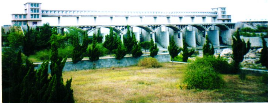
门楼水库溢洪闸
