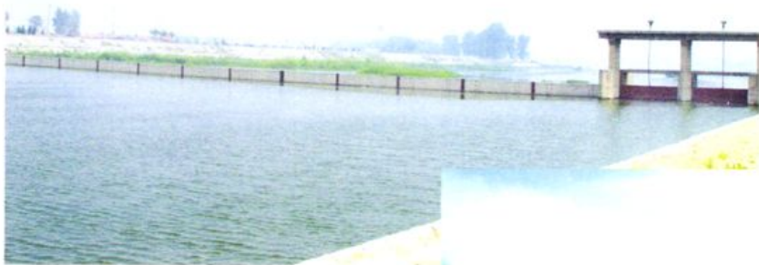
内夹河第二道 翻板闸
