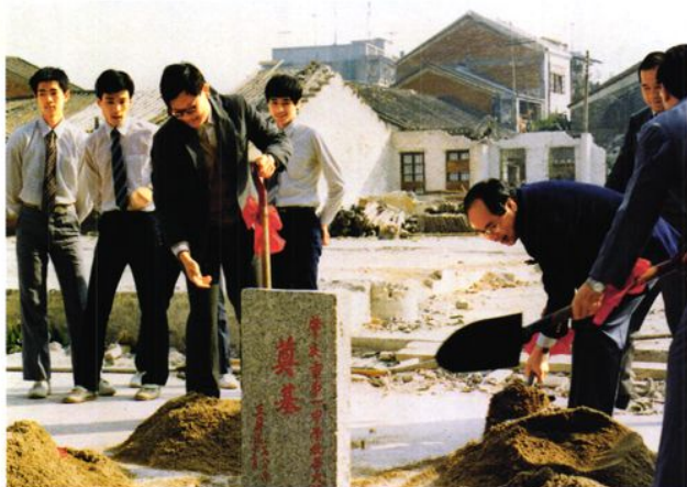
1986年11月29日，省、地、市领导参加市一中教学大楼奠基仪式
