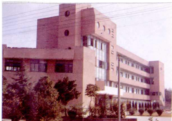
安徽省池州供销学校教学楼
