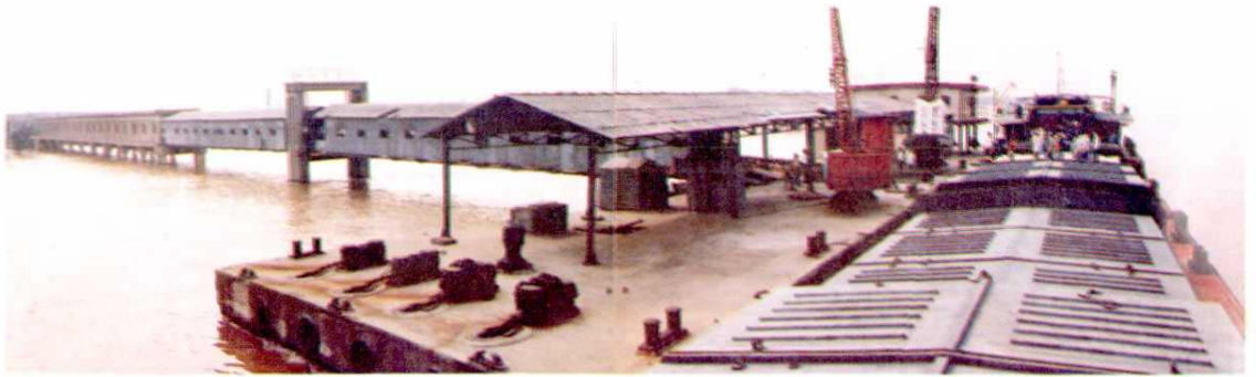
二坝化肥中转库 1 号码头
