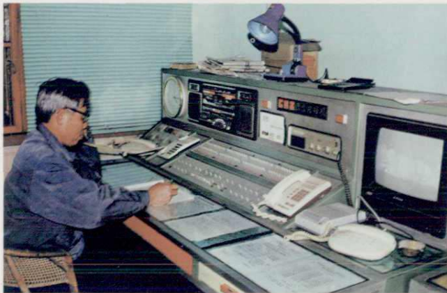
煤矿生产调度室
