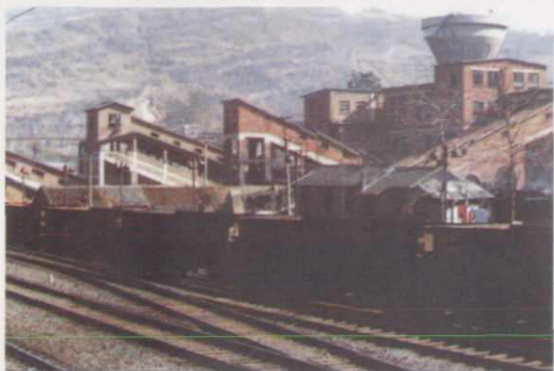
南岭煤矿坪石洗煤厂
