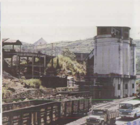
煤矿圆筒煤仓
