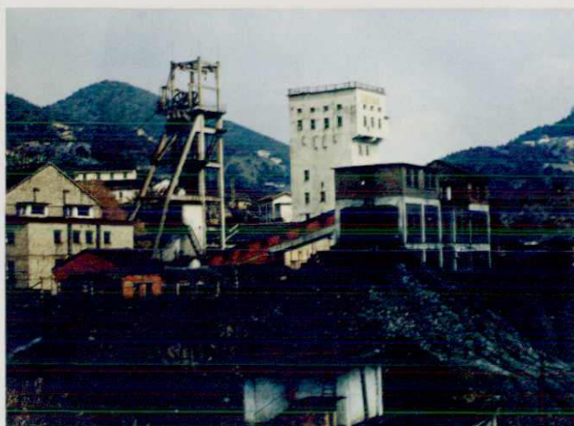
四望嶂矿务局四望嶂矿(一矿)立井, 采用 塔式摩擦轮提升机提升
