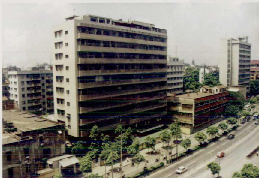
广东省煤炭工业总公司办公楼
