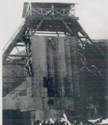
建设中的曲仁煤矿云顶立井 (1958年)
