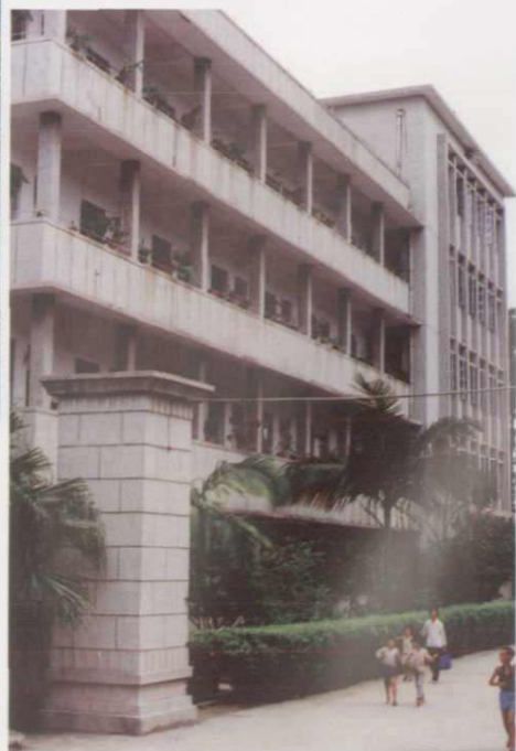
茂名矿务局办公楼
