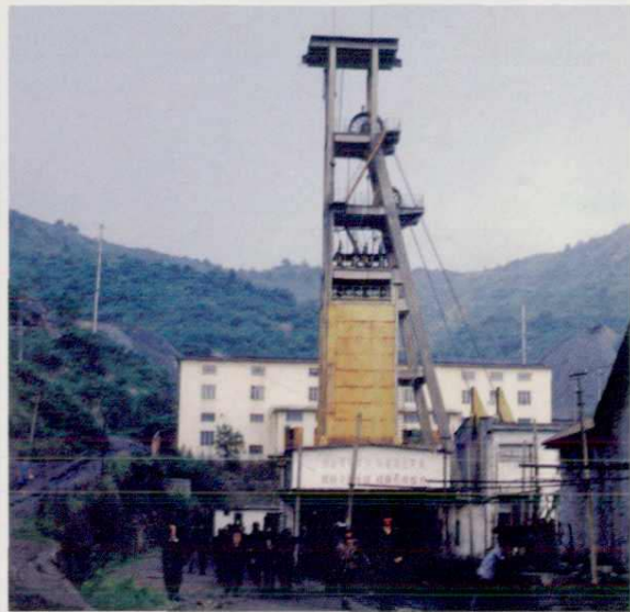
曲仁矿务局格顶矿(三矿)立井, 采 用落地式摩擦轮提升机提升
