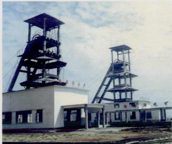
梅县矿务局槐岗煤矿主、副井。这 是省属煤矿最晚建成的一对立井
