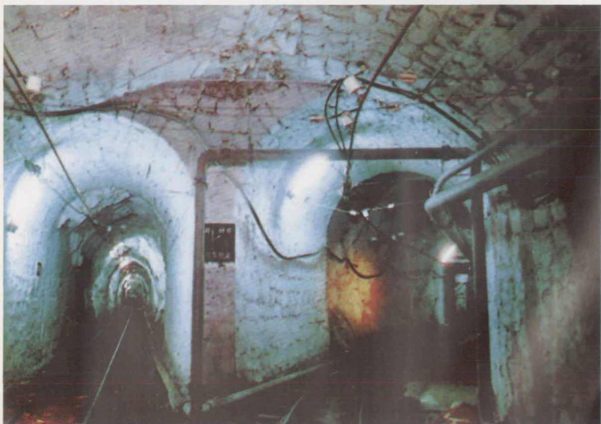
煤矿井下交岔点
