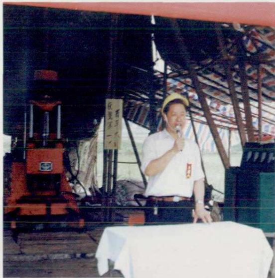
广东省煤田地质勘探公司首次 使用千米液压钻机(1987年)
