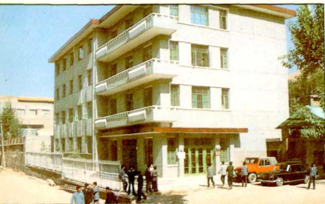
延长县石油钻采公司办公楼
