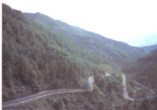
2001~2002年，县财政投入公路交通建设专项资金9217万元。图为修建竣工后的双江路（通江至南江）。
