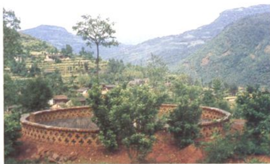
县财政积极支持农田水利基础设施建设，全县修建蓄水池248口。
