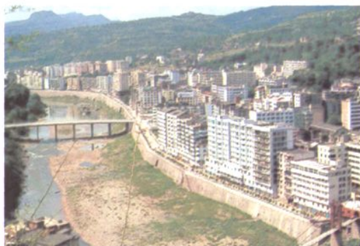
财政投资修建的通江滨河路。
