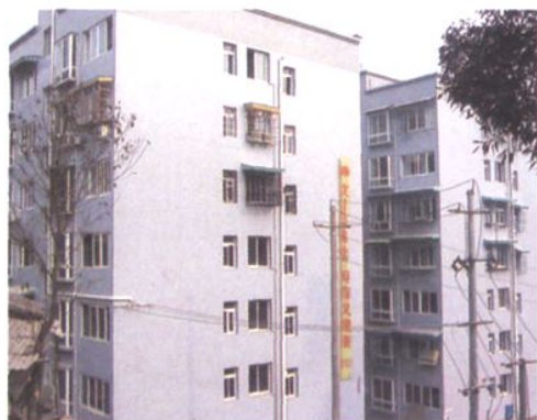
2003年9月14日动工兴建的林化小区财政局职工住宅楼。
