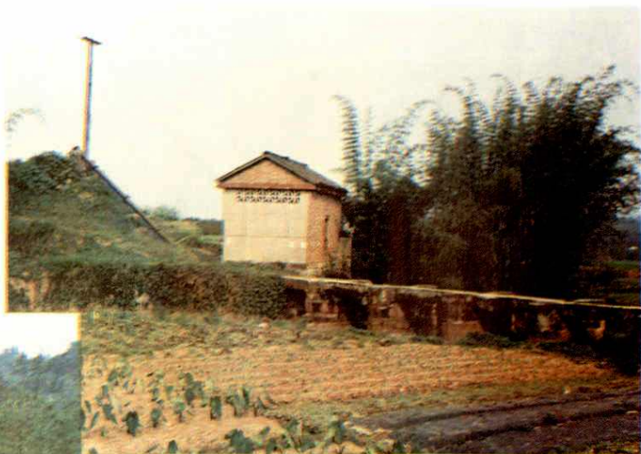
李加桥电灌站 ▶
