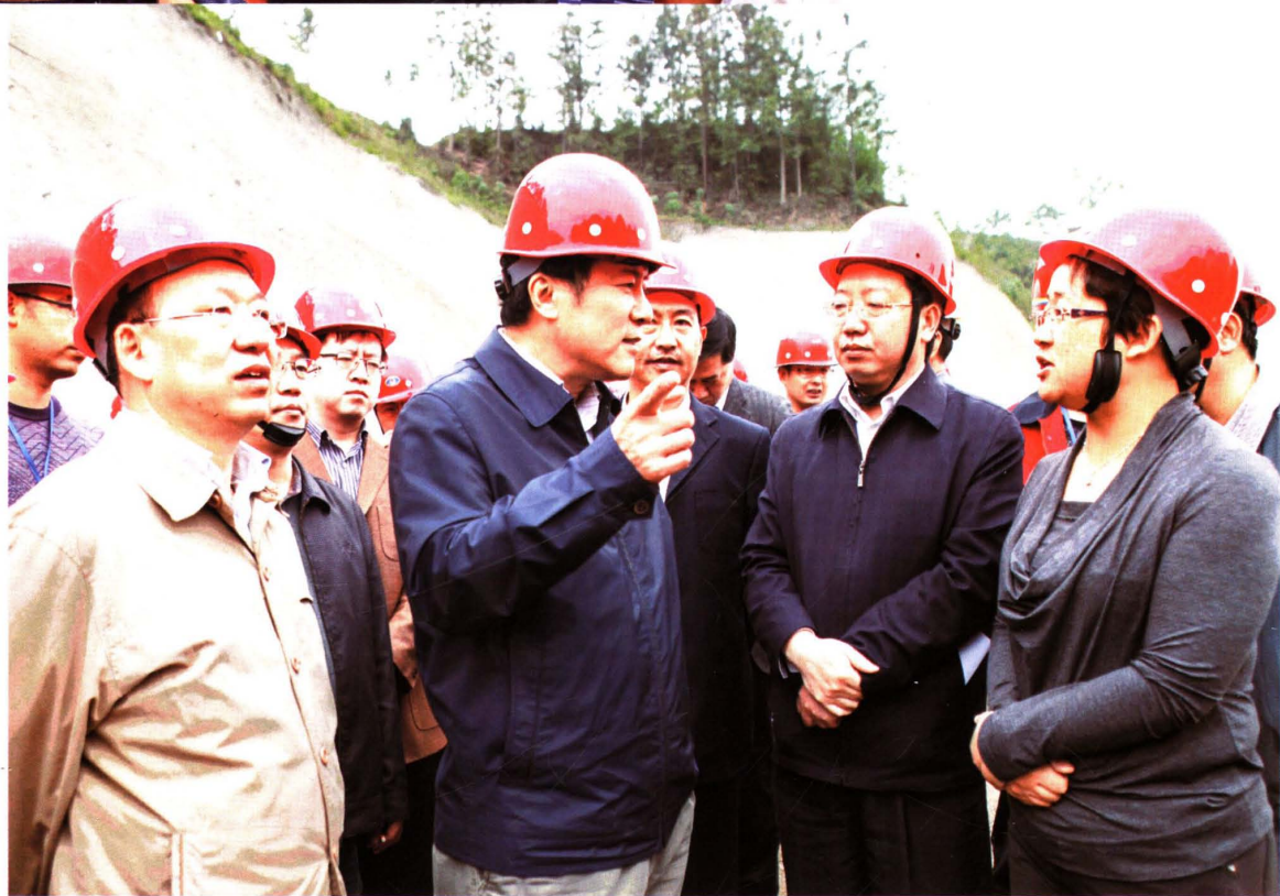
水利部副部长矫勇（左二）在副省长刘远坤（左一）、毕节市副市长李玉平（左三）、大方县委书记张瀚时（右二）、副县长章育（右一）的陪同下，视察正在建设的岔河水库工程安全度汛准备。
