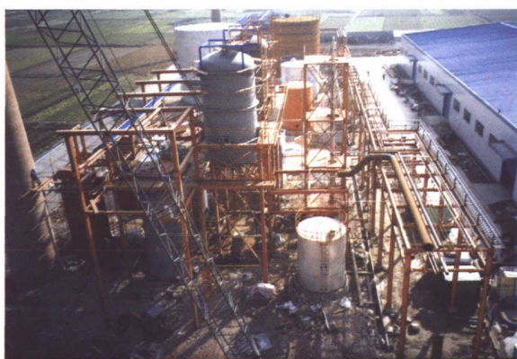
▲荣盛化纤聚酯一期建设现场
