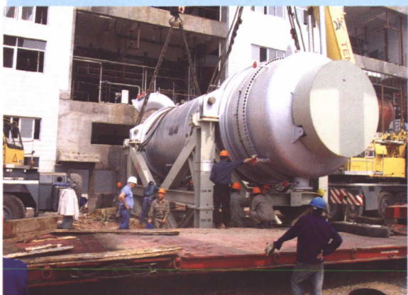
▲荣盛化纤聚酯二期建设现场
