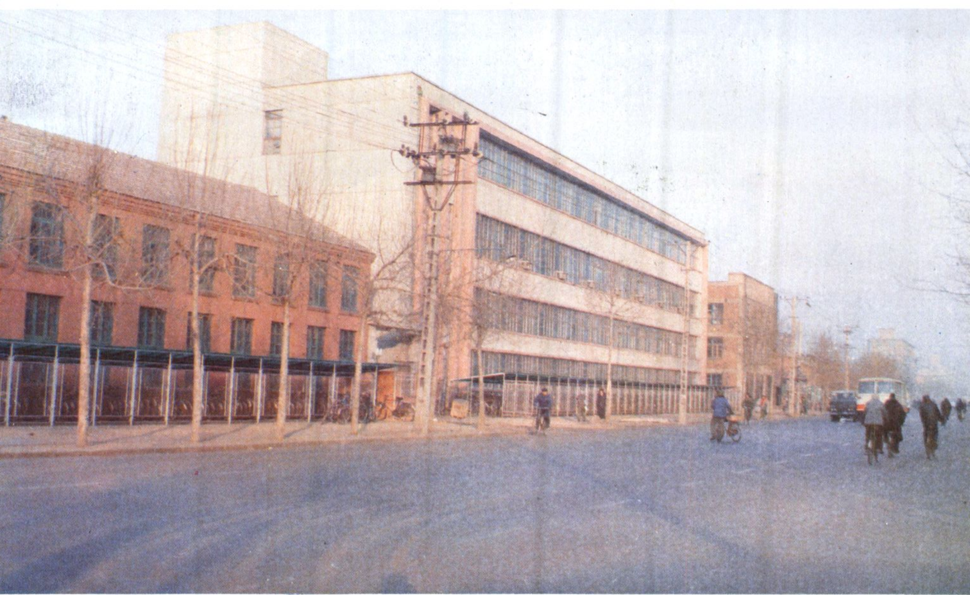
工厂新建设的封闭式的具有现代化装备的总装车间
